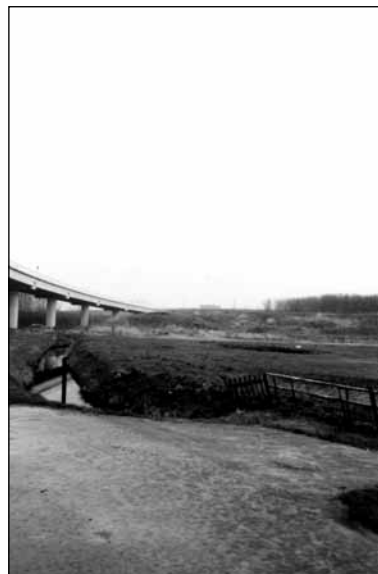
Afbeelding 19: We staan op het punt waar we in afbeelding 16 naar toe keken. Links in de lucht hangt het metroviaduct. Op de achtergrond is de A15 te zien (foto: Wilco van Erven)
