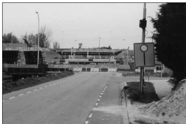
Nootdorp, de Veenweg in de richting van de te verlengen tunnel onder de A12 (foto: Eddie Kips)
