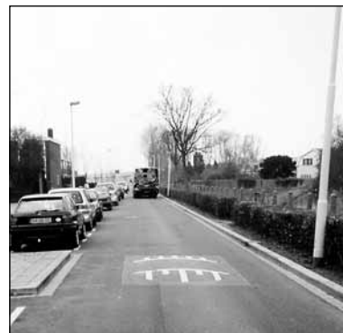
Afbeelding 12: Voor fietsers gevaarlijke snelheidsbegrenzer (foto: Wilco van Erven)
