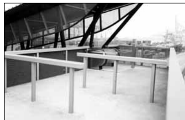
Afbeelding 14: Hek dat moet voorkomen dat fietsers hun weg vlot via het fietspad kunnen vervolgen (foto: Wilco van Erven)
